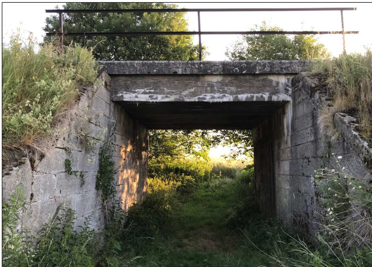
Obr. 1: Most deskové konstrukce v km 77,067
